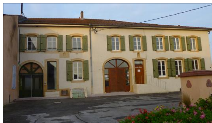
Le bâtiment abritant la mairie et l'école est désormais comme neuf. L'extérieur comme l'intérieur ont été rénovés. Photo DR.
